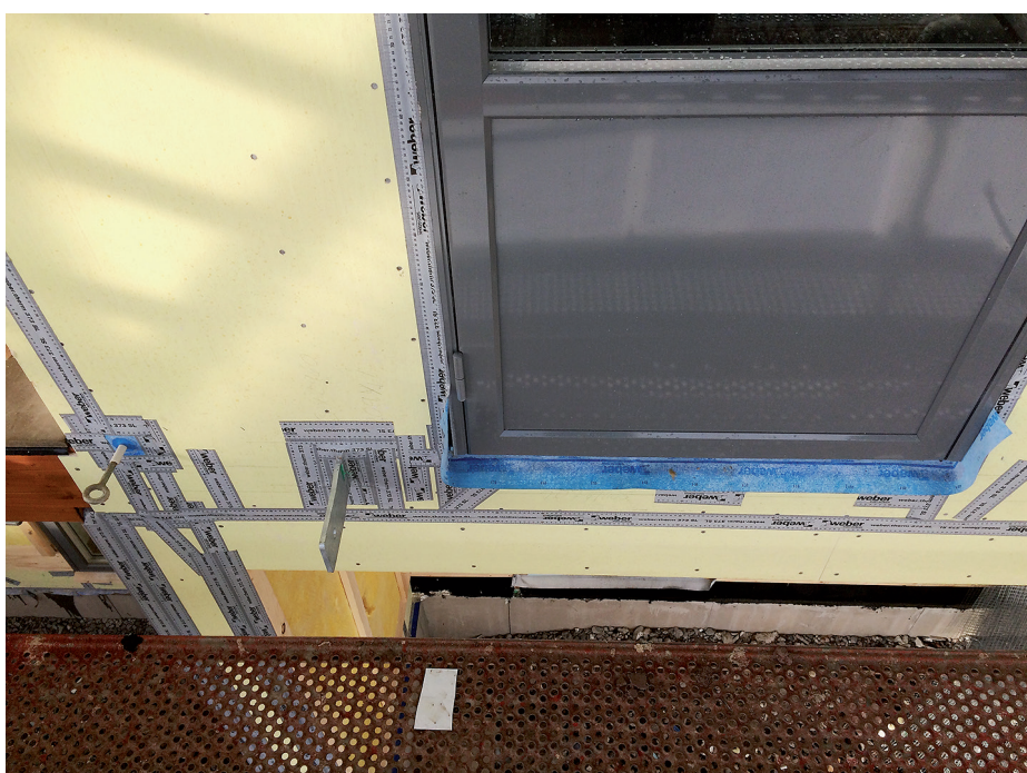
Webers tejp på fasaden och Isola Flexwrap under balkongdörren.
