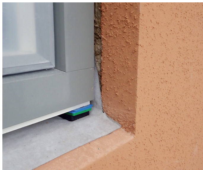
Butylband under fönster i betongsandwich.
