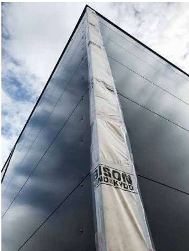
Figur 3: Stomskydd vid ytterhörn med fasadkassetter.
