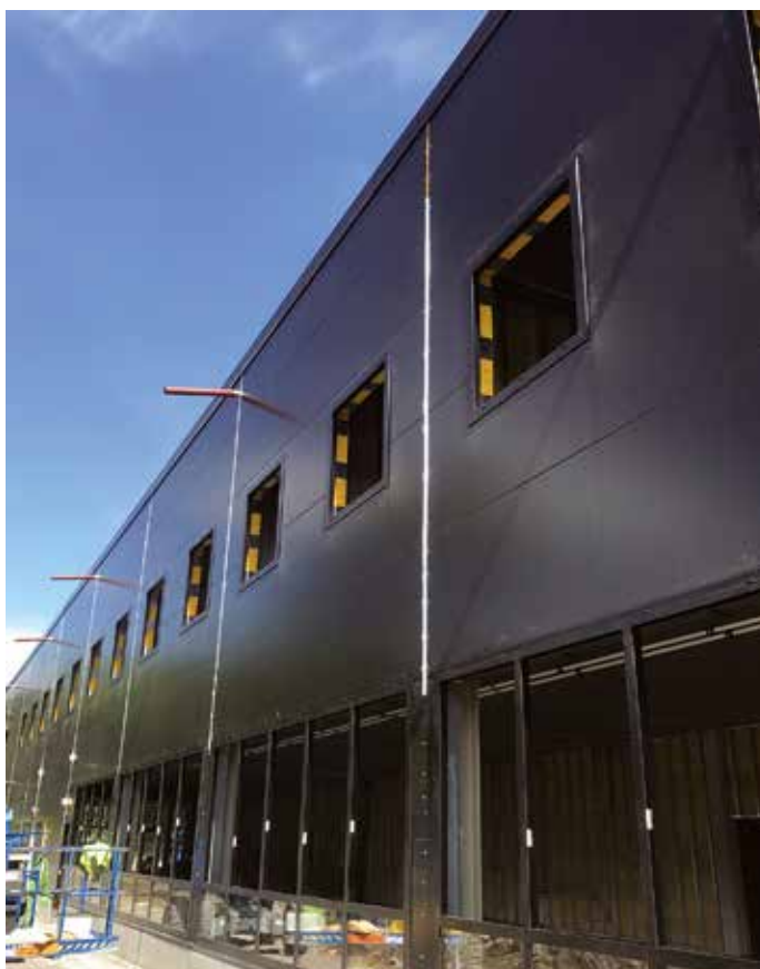
Bild 1: Fasadkassetter tejpas täta i vertikala skarvar på utsidan.
