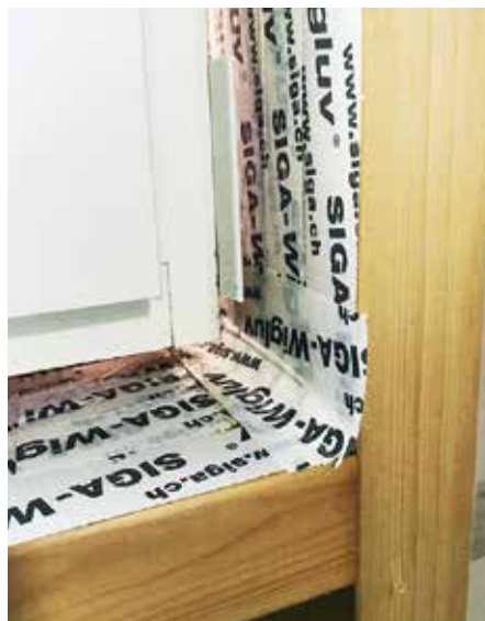
Figur 8: Sekundärtätning under fönsteröppningar ska utföras
