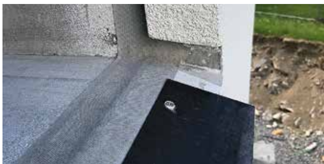
Figur 10: Sekundärtätning under fönster vid Sandwichväggar i betong.
