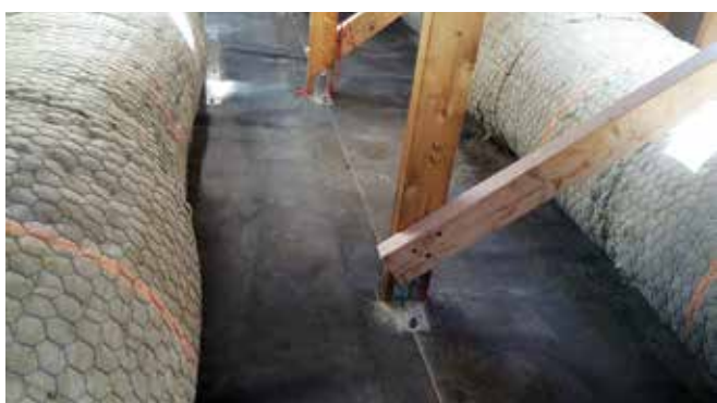
Figur 5: Helklistrat tätskikt som stoppar byggfukt på vinden när den görs oventilerad.
